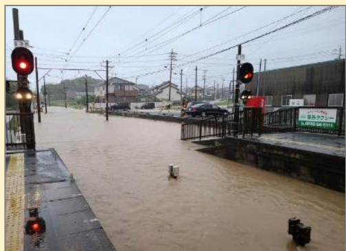
○令和5年6月台風2号接近時の老津駅構内
